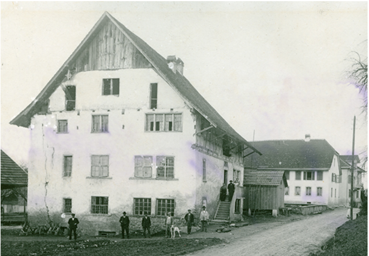
Färberei- und zeitweiliges Wirtshaus in Leimbach kurz vor dem Abbruch im Jahr 1912
