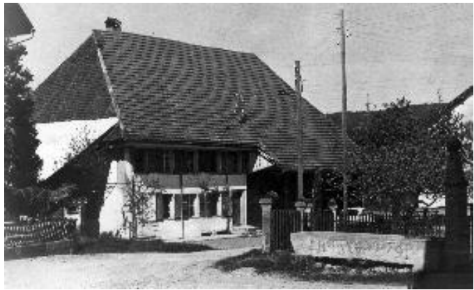
Brunnen bei der Mühle, 1791 von Heinrich Häfeli errichtet.
